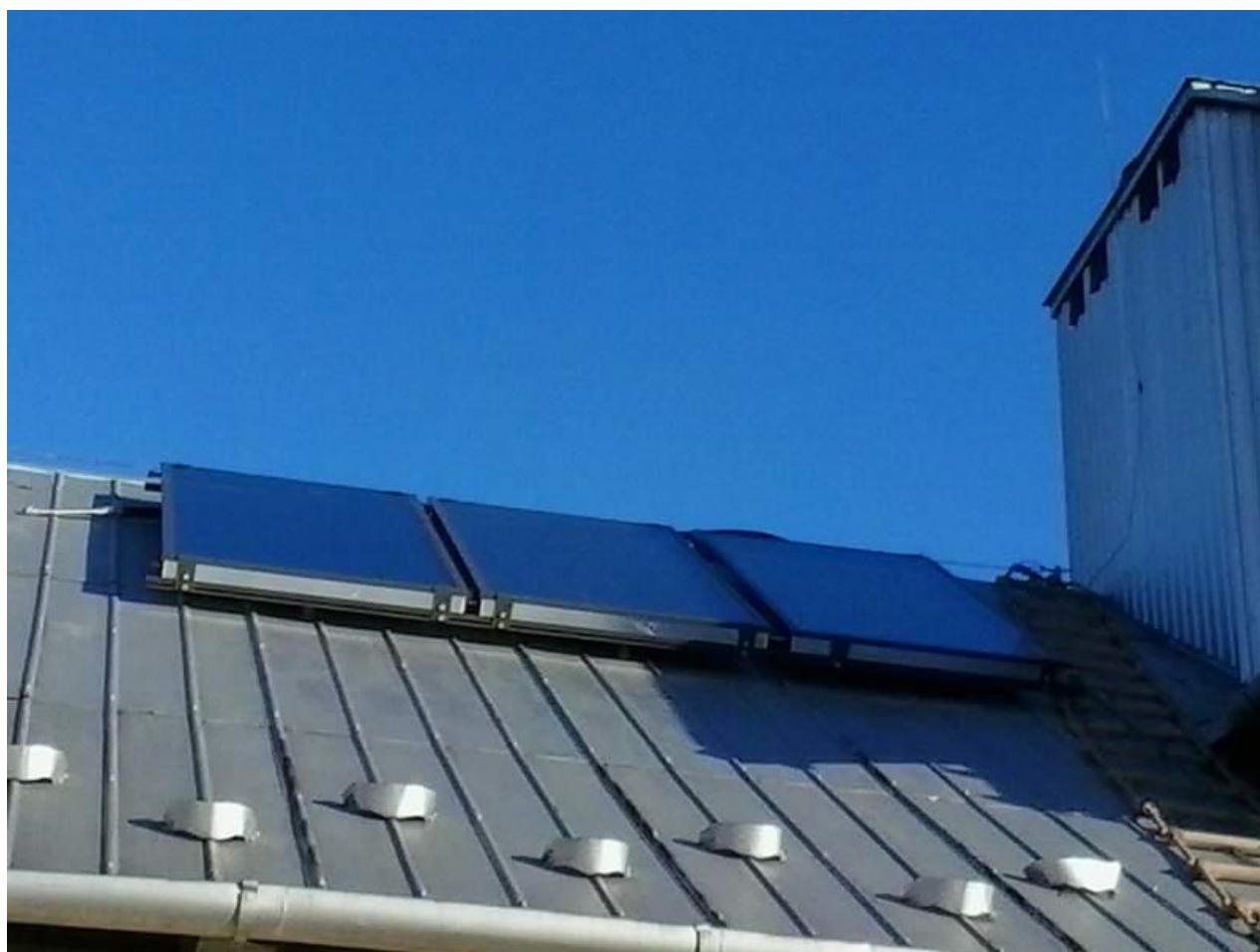
Po montażu kolektorów
