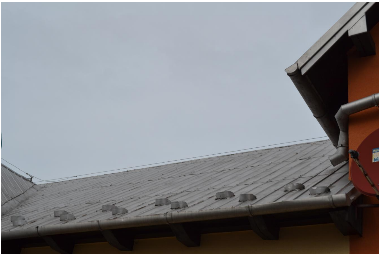
Przed montażem kolektorów
