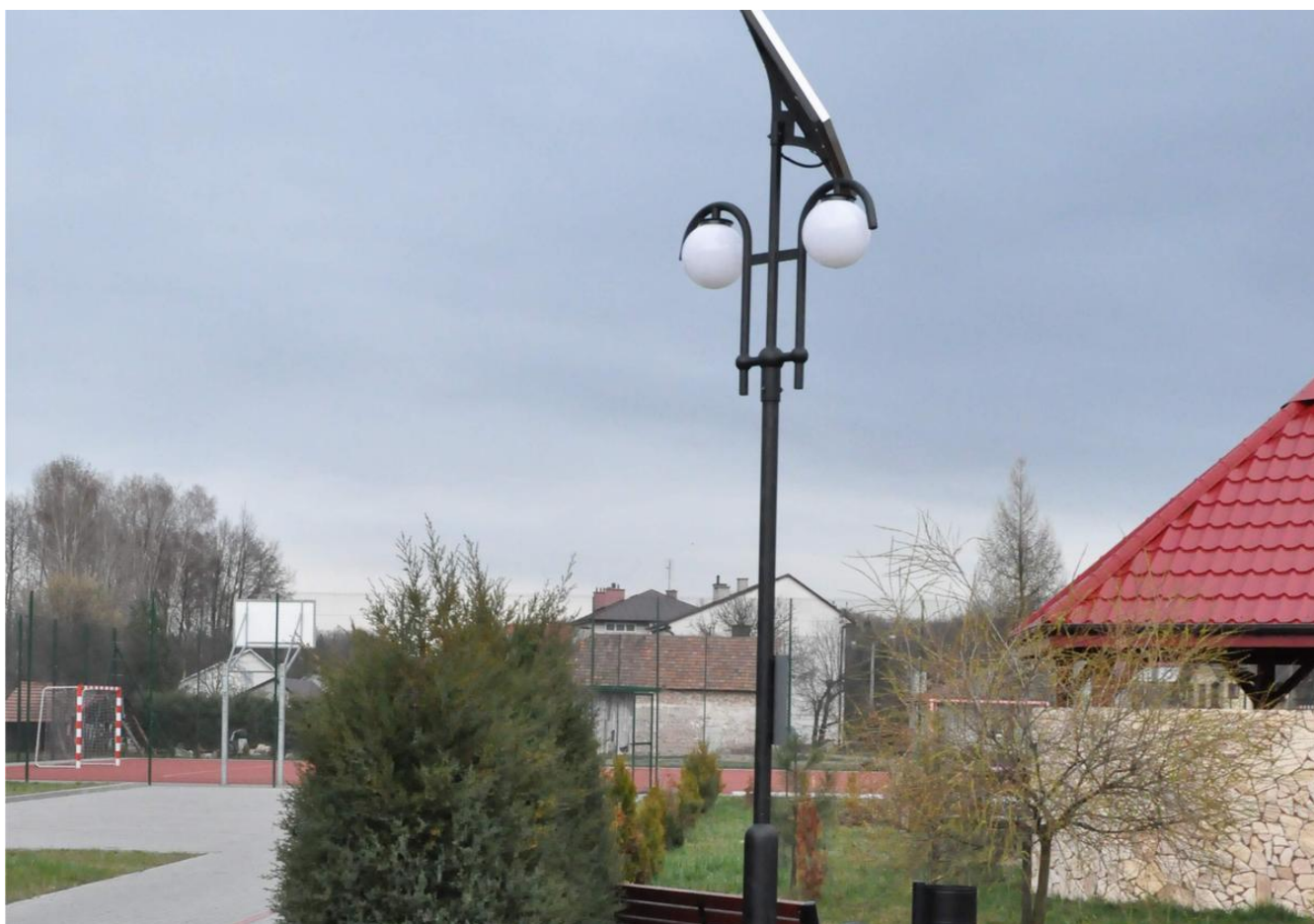
Po montażu lampy z panelami fotowoltaicznymi
