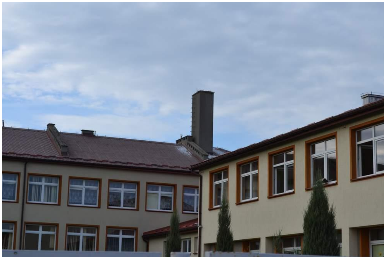
Po montażu nowej platformy gniazda bocianiego
